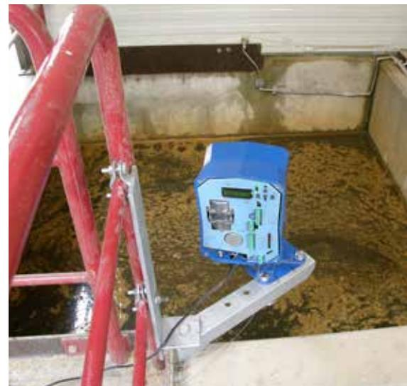
Medición **interfase** en tanques de sedimentación
